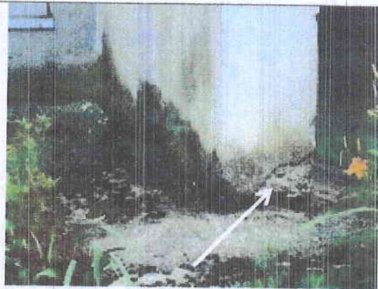
Pav. 8 Vietomis, nuo cokolinės pastato dalies atšokęs tinkas.
