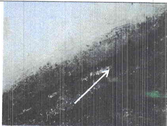
Pav. 2 Iš pastato šono ir galo nusidėvėjusi ir nusėdusi nuogrinda.
