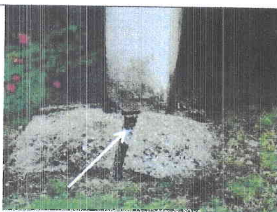
Pav. 3 Iš pastato šono ir galo nusidėvėjusi ir nusėdusi nuogrinda.
