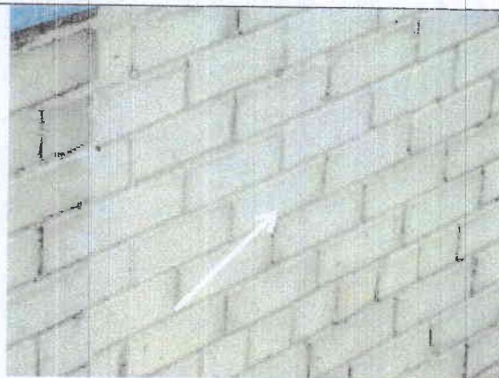
Pav. 12 Nusidėvėjęs plytų paviršius (ypač viršutiniuose aukštuose), į tokias plytas lengvai gali įsigerti vanduo, žiemos metu vanduo šaldamas ardo plytų paviršių, prastėja pastato termoizoliacinės savybės.
