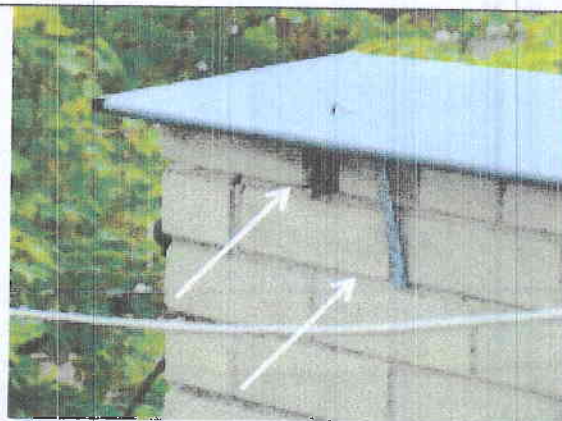
Pav. 10 Nusidėvėjęs plytų paviršius (ypač viršutiniuose aukštuose), į tokias plytas lengvai gali įsigerti vanduo, žiemos metu vanduo šaldamas ardo plytų paviršių, prastėja pastato termoizoliacinės savybės.
