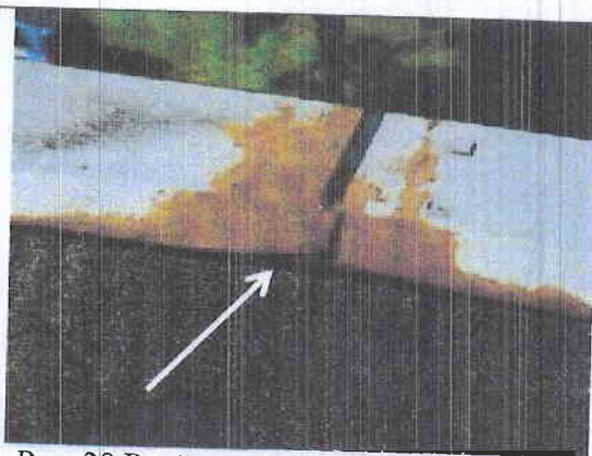
Pav. 28 Per žemas pastato parapetas, esant didesniai lietaus kiekiui vanduo gali palysti po parapeto apskardinimu ir sudrėkinti sieną.
