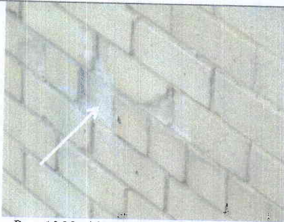
Pav. 13 Nusidėvėjęs plytų paviršius (ypač viršutiniuose aukštuose), į tokias plytas lengvai gali įsigerti vanduo, žiemos metu vanduo šaldamas ardo plytų paviršių, prastėja pastato termoizoliacinės savybės.
