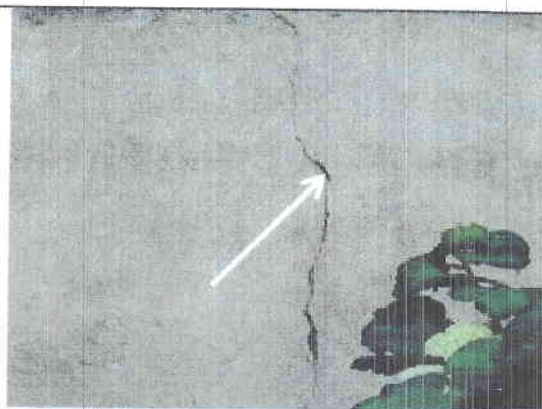
Pav. 4 Cokolinėje pastato dalyje matomi įtrūkimai.
