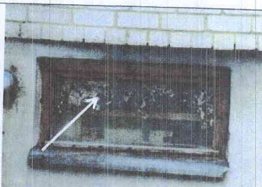
Pav. 30 Nusidėvėjusi dalis pastato rūšio langų.
