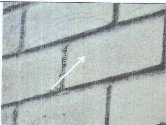
Pav. 9 Nusidėvėjęs plytų paviršius (ypač viršutiniuose aukštuose), į tokias plytas lengvai gali įsigerti vanduo, žiemos metu vanduo šaldamas ardo plytų paviršių, prastėja pastato termoizoliacinės savybės.
