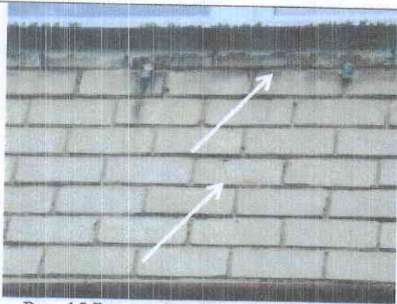
Pav. 15 Pastato fasade matomas smulkus įtrūkimas.
