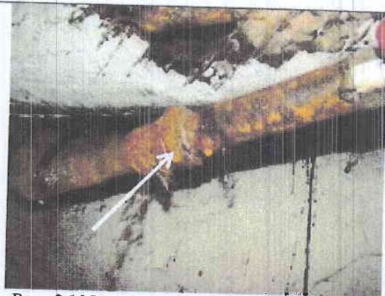
Pav. 26 Nusidėvėjęs vandentiekio ir karšto vandens vamzdynas, vietomis vamzdynas koroduoja, neapšiltintas.
