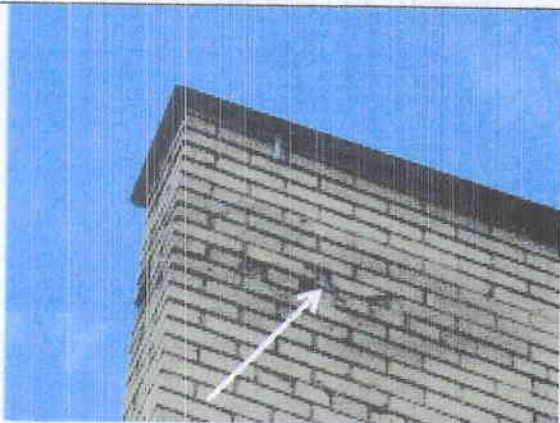
Pav. 11 Nusidėvėjęs plytų paviršius (ypač viršutiniuose aukštuose), į tokias plytas lengvai gali įsigerti vanduo, žiemos metu vanduo šaldamas ardo plytų paviršių, prastėja pastato termoizoliacinės savybės.
