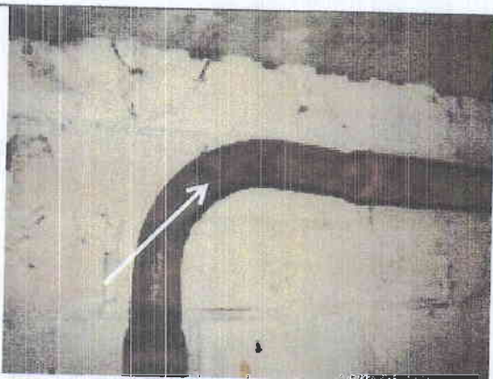
Pav. 23 Nusidėvėjęs vandentiekio ir karšto vandens vamzdynas, vietomis vamzdynas koroduoja, neapšiltintas.
