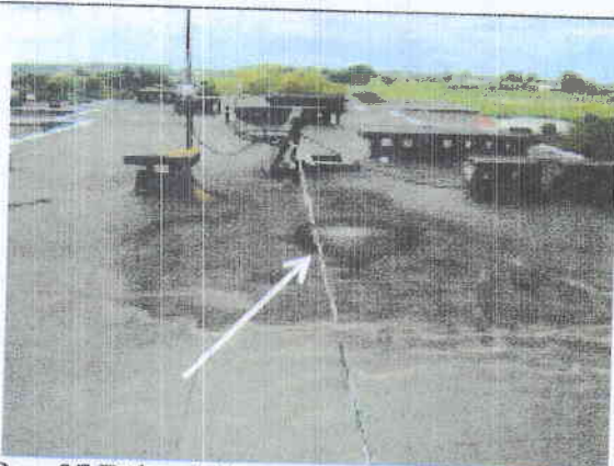
Pav. 27 Dėl netinkamo stogo nuolydžio pastato viduryje, po lietaus, susidaro pelkė.
