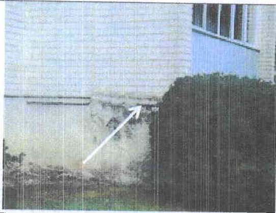
Pav. 7 Vietomis, nuo cokolinės pastato dalies atšokęs tinkas.
