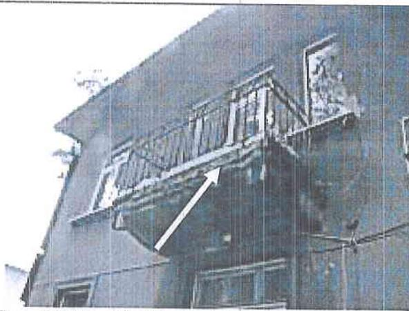
Pav. 21 Nusidėvėjė pastato balkonai, sudrėkusi visa plokštė, aižėja betoninis paviršius, surūdiję turėklai.
