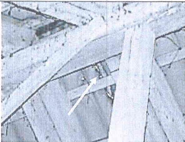
Pav. 25 Nusidėvėjusi asbestcementinė stogo danga. Dangoje matomi tarpeliai, per kuriuos į pastato vidų gali prasiskverbtis vanduo.
