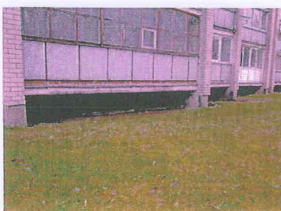
6 pav. Balkonų konstrukcija
