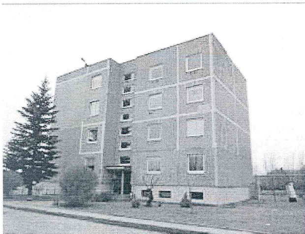
1 Pav. Šiaurinis fasadas.
