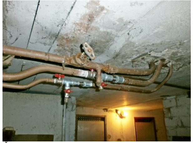
Šalto ir karšto vandentiekio tinklai
