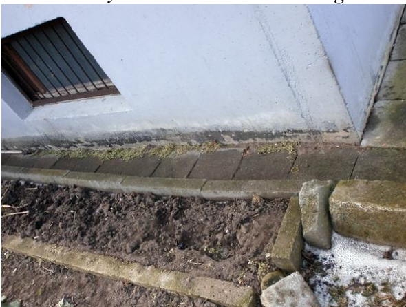
Nuogrinda iš betoninių plytelių
