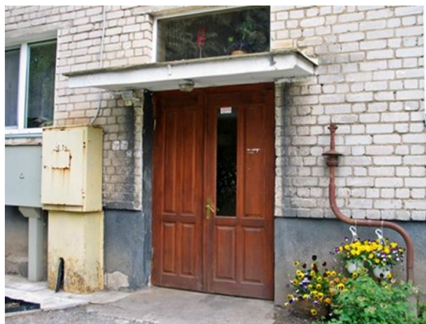
Įėjimo durys pakeistos naujomis medinėmis, neapšiltintomis, laiptinės langai nauji pvc
