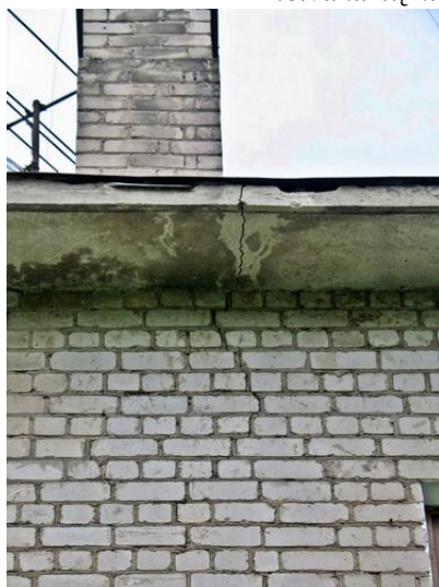
Trūkimas mūre ir karnizinėje plokštėje
