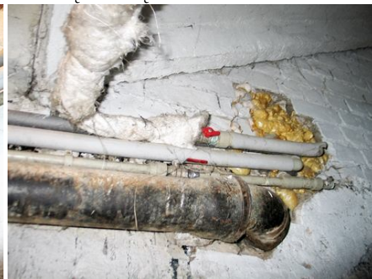
Šalto ir karšto vandentiekio sistemų magistralės ir stovai pakeisti
