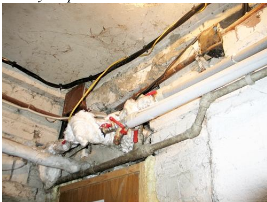
Šalto ir karšto vandentiekio sistemų magistralės ir stovai pakeisti
