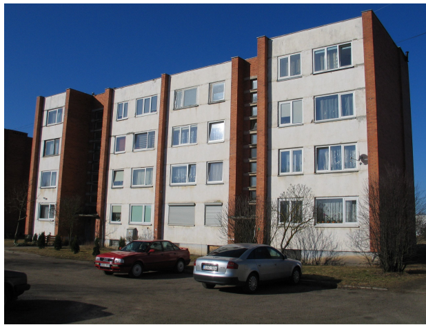
1 Pav. Šiaurinis fasadas.
