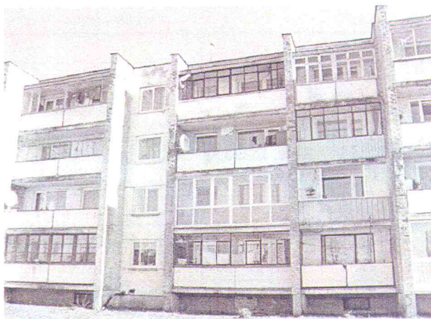
Gatvės fasadas (vakary)
