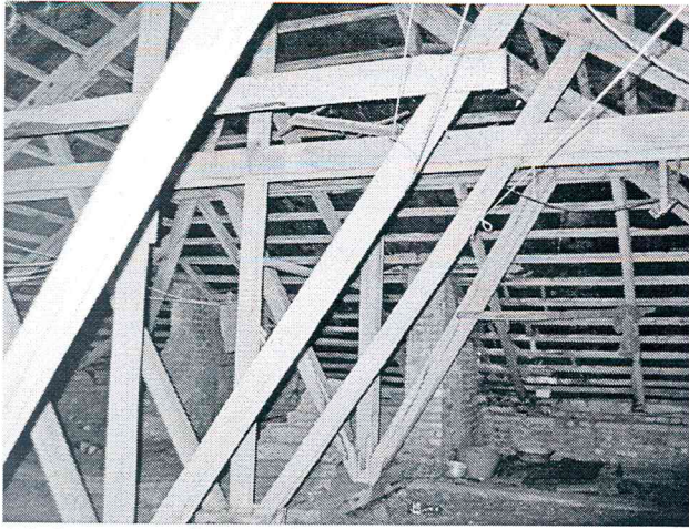
Medinė stogo konstrukcija
