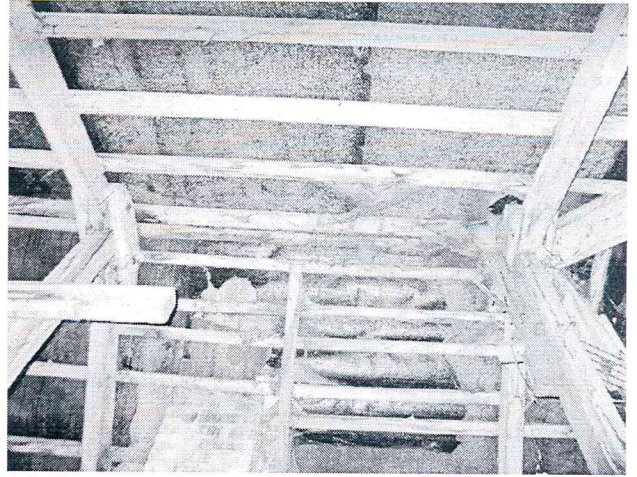
Medinė stogo konstrukcija
