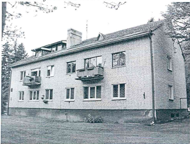
Rytų (gatvės) fasadas
