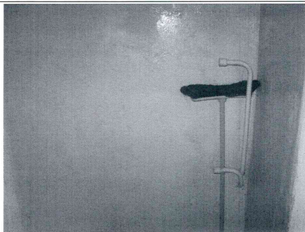
Dalis laiptinės radiatorių demontuota
