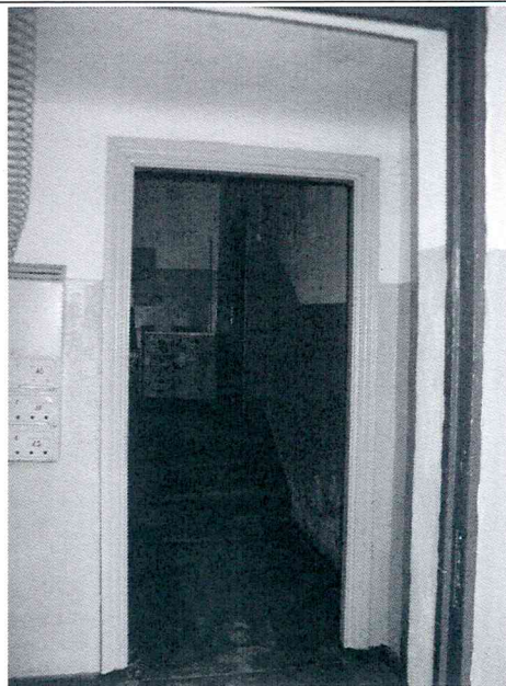
Senos tambūrų durys, varčia išmontuota
