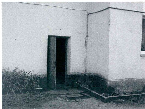
Senos laiptinės durys, apirę įėjimo laipteliai,
