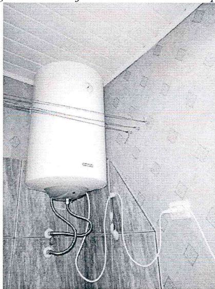
Karšto vandens ruošimas elektriniais pašildytuvais butuose
