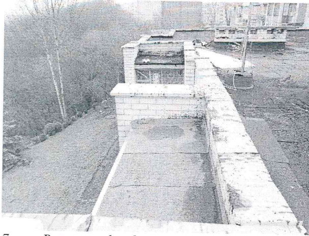
7pav. Parapetų skardinimas, balkonų stogeliai
