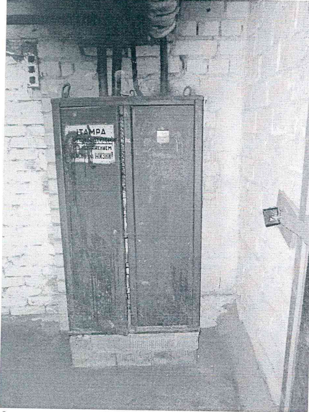
9pav. Įvadinė el.spinta
