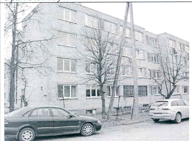
3 pav. Šiaurinis fasadas
