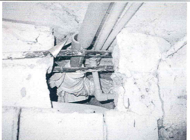
Dalis vandentiekio vamzdžių pakeista, bet neizoliuota
