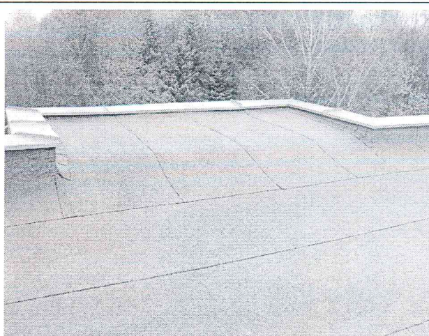
Stogeliai virš laiptinių lodžių, nėra apsauginės tvorelės
