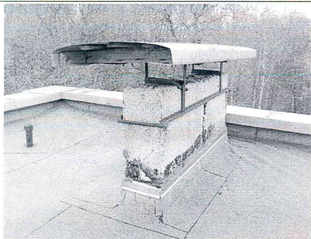
Vėdinimo kanalai- remontuoti stogeliai
