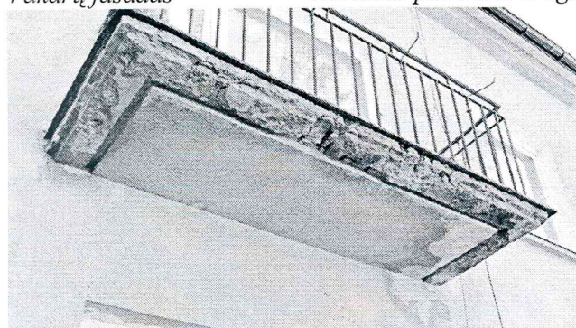
Balkono laikanti konstrukcija
