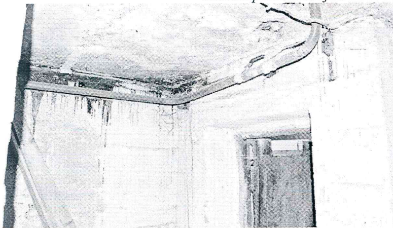
Šalto vandentiekio magistralinis vamzdis
