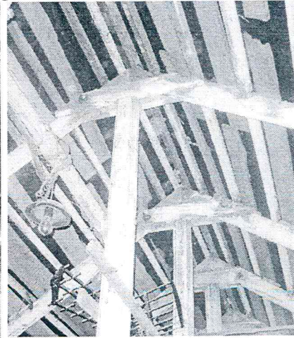
Medinė stogo konstrukcija
