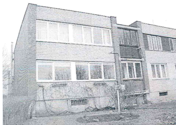
5 pav. Galinis fasadas, balkonų atitvaros
