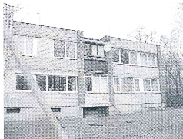
6 pav. Galinis fasadas, balkonų atitvaros
