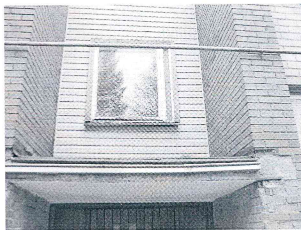
12pav. Nepakeistos lauko durys ir laiptinės langai
